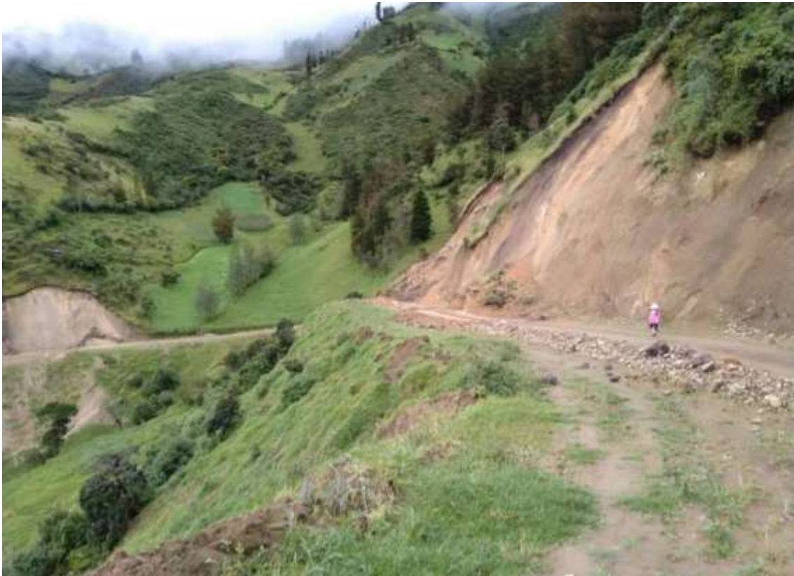
Fotografía 15.- Vía de acceso a las parroquias con susceptibilidad alta a la amenaza de deslizamiento. Autores: Yazuma, Piuri, 2021.
