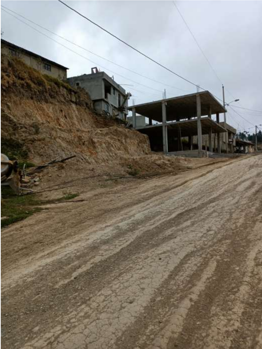
Fotografía 16.- Viviendas ubicadas en zonas susceptibles a deslizamientos.
