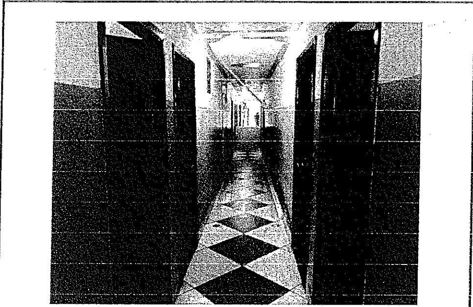
Fotografía N° 6.- de semi-conjunto del área destinado para pasillo.
