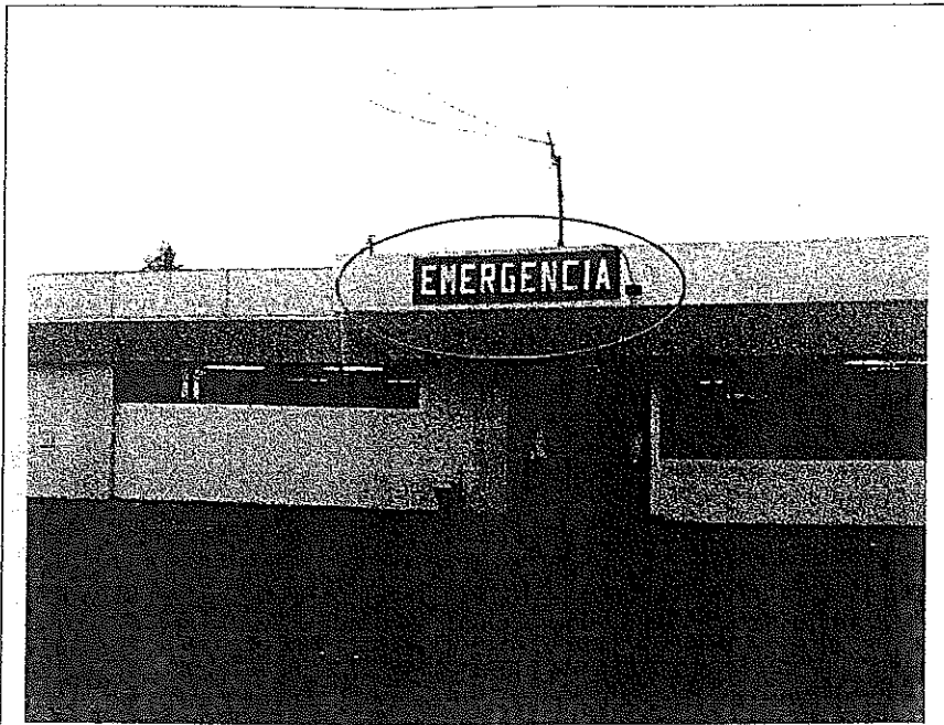
Fotografía donde se aprecia la edificación y el epigrafe que se lee: EMERGENCIA, lugar de reconocimiento.
