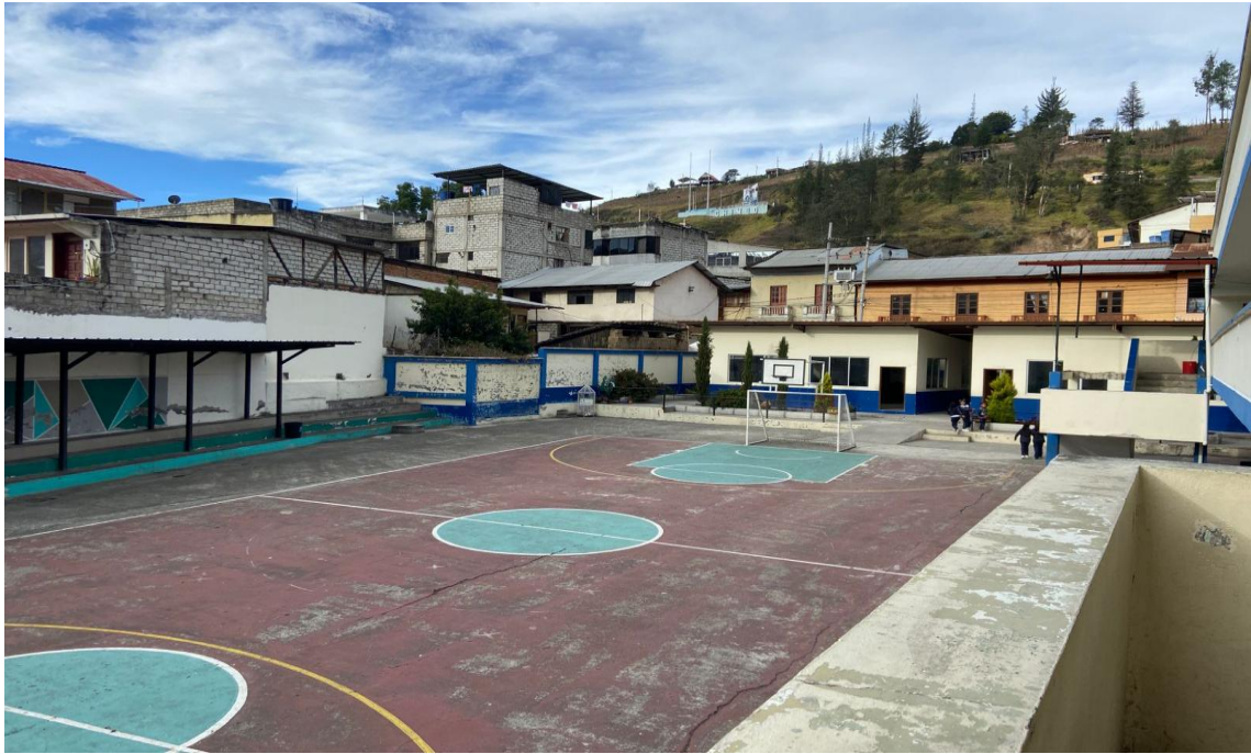
Figura 8. Infraestructura de la escuela de educación básica
