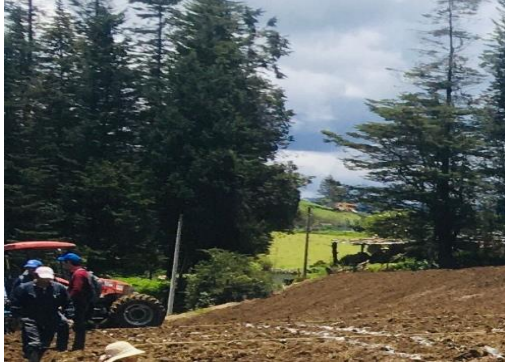
Preparación del terreno
