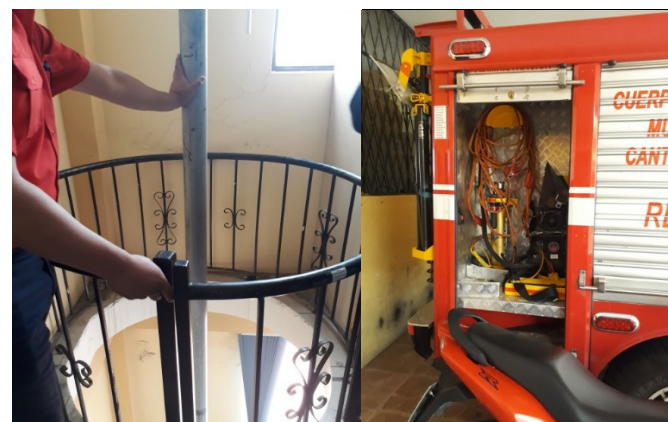
Foto N o . 9: Salida de emergencia Autoras: Diana Gaibor y Jesenia Valverde, 2018
