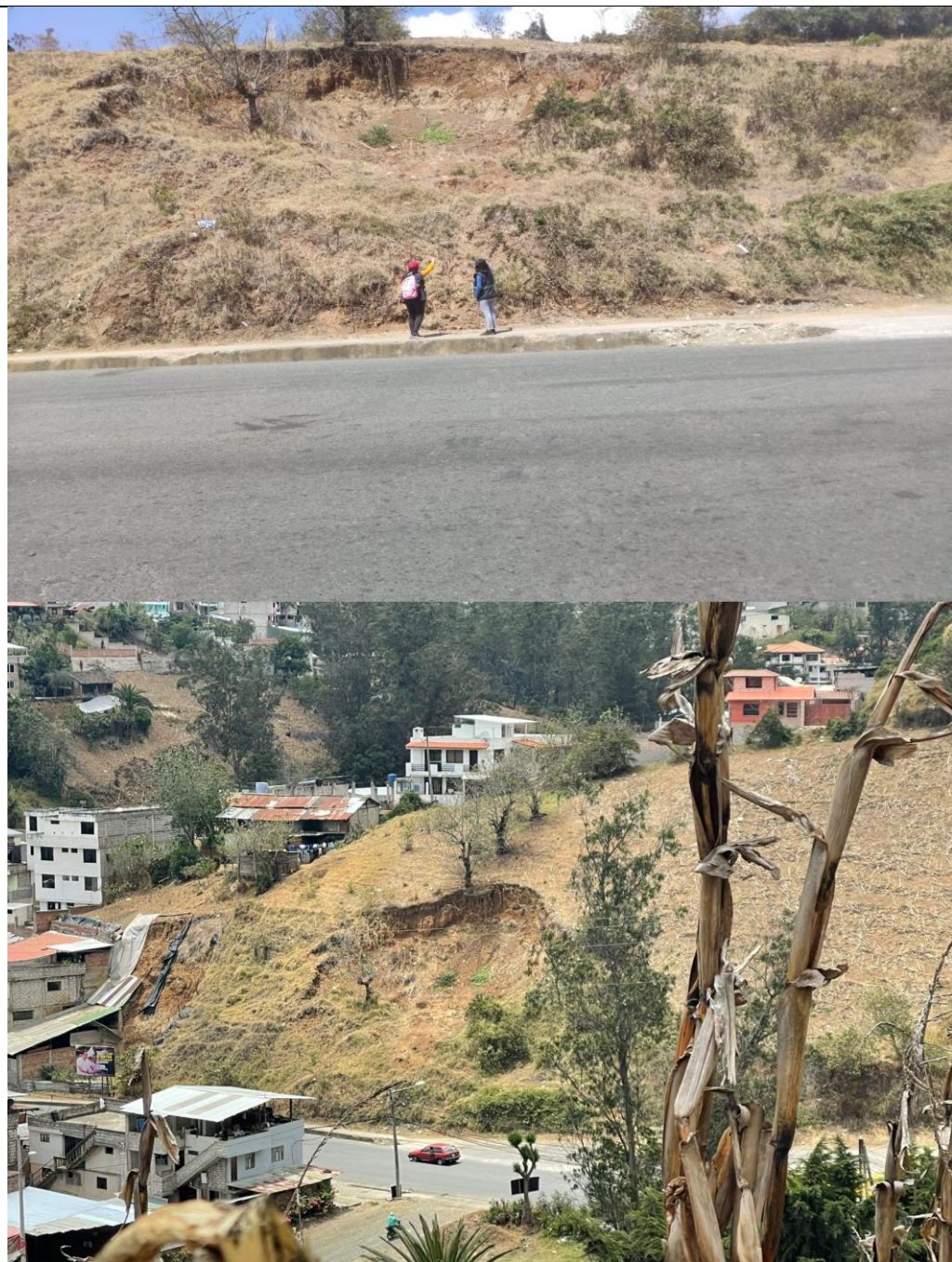
Fotografía N°1. Observación de campo en el Barrio América
