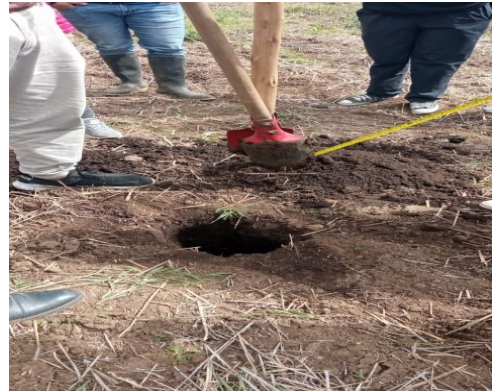
Elaboración de una calicata
