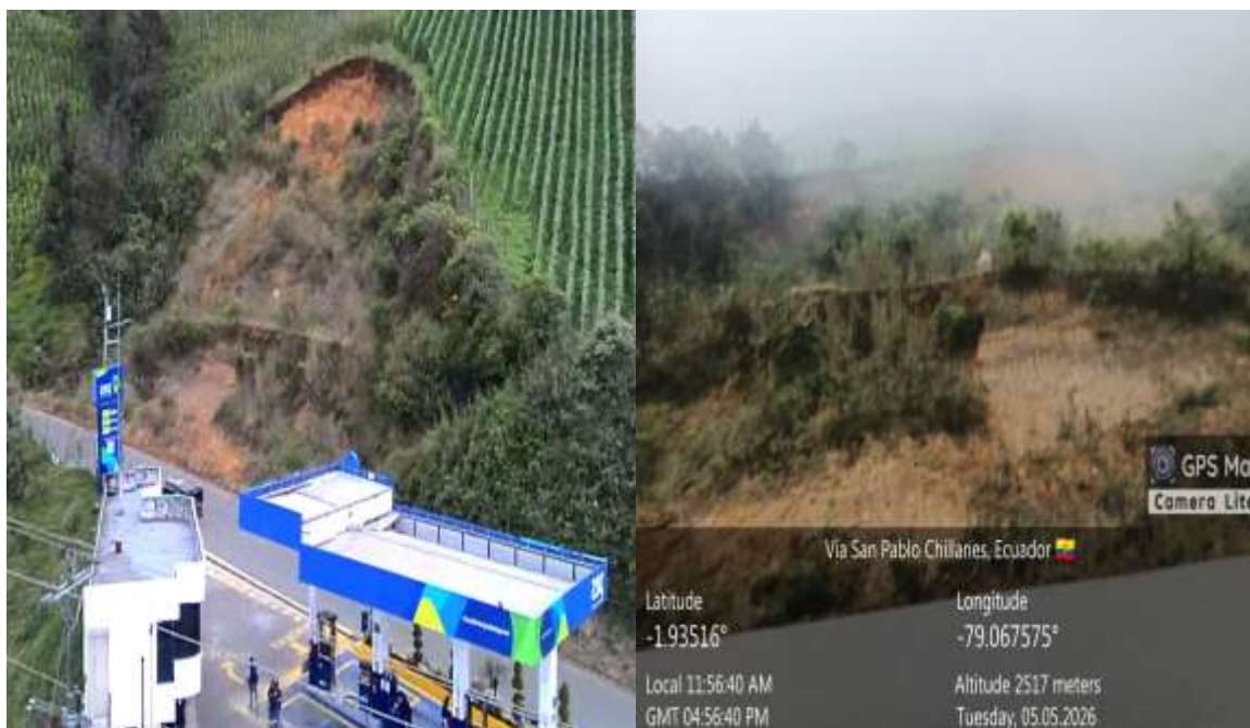
Imagen A2.2: Punto de control en sector "La Gasolinera"
