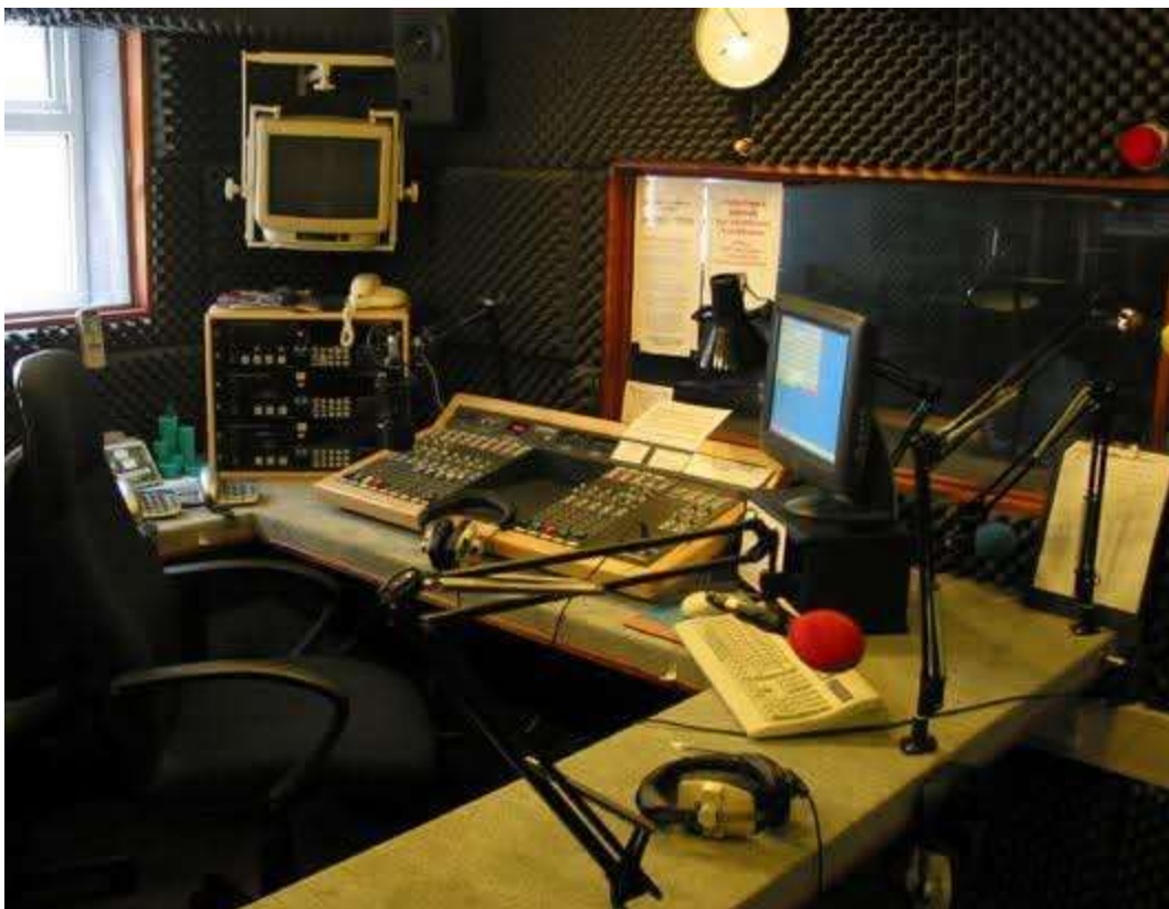
Anexo 7. Fotografías de las instalaciones con Fecha el 09 De noviembre 2024
