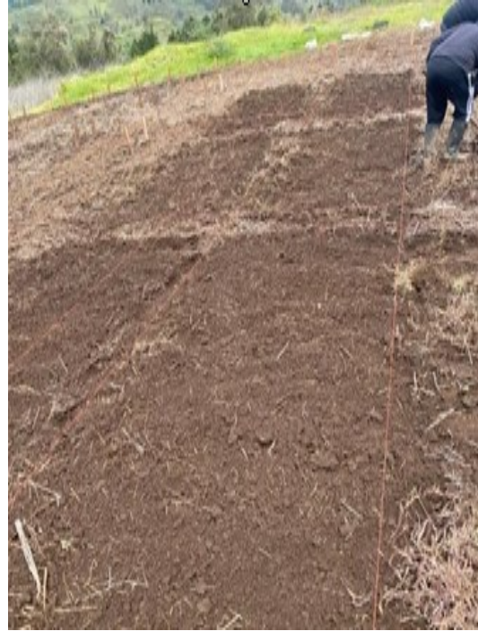
Nivelación del terreno
