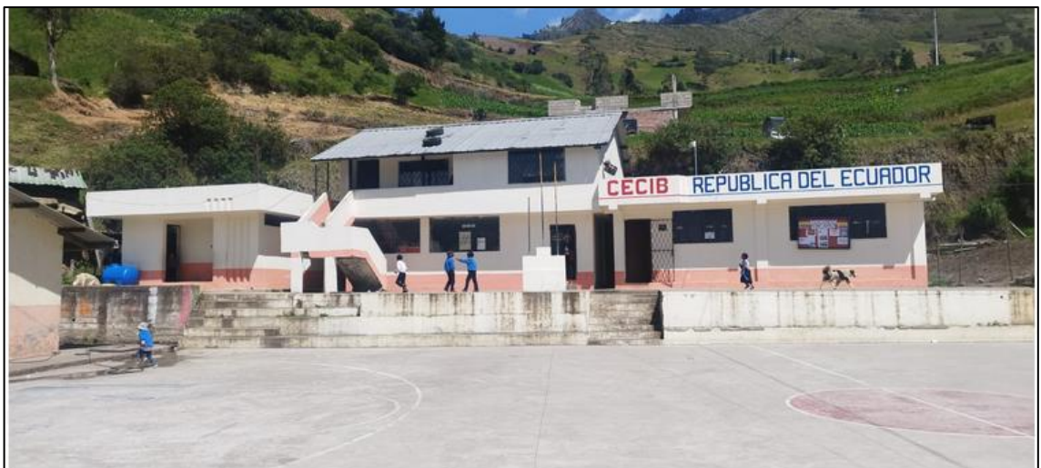
Ilustración 61 Instalaciones del CECIB "República del Ecuador"
