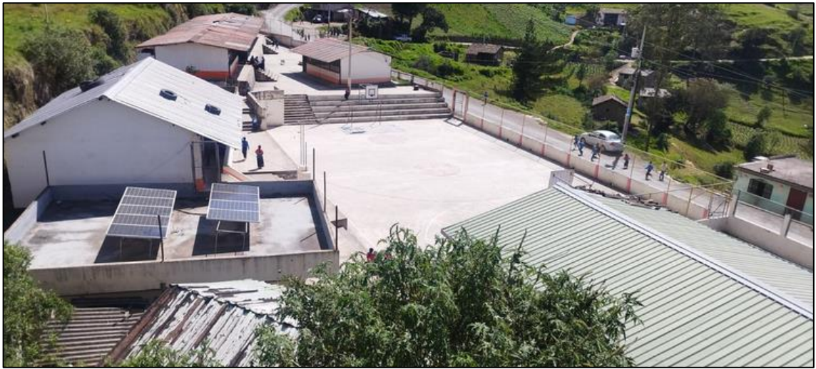
Ilustración 60 Instalaciones del CECIB "República del Ecuador"
