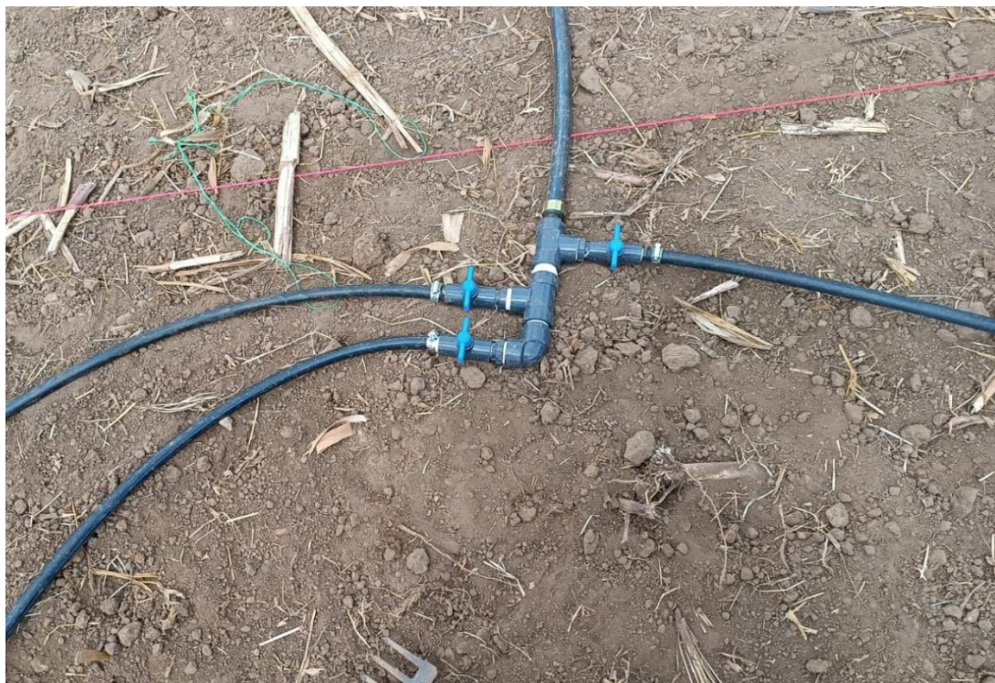
Instalación del sistema de riego.
