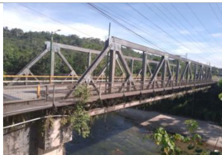
Ilustración 12: Puente Celosía de tipo Warren, sobre el Río Tena.
