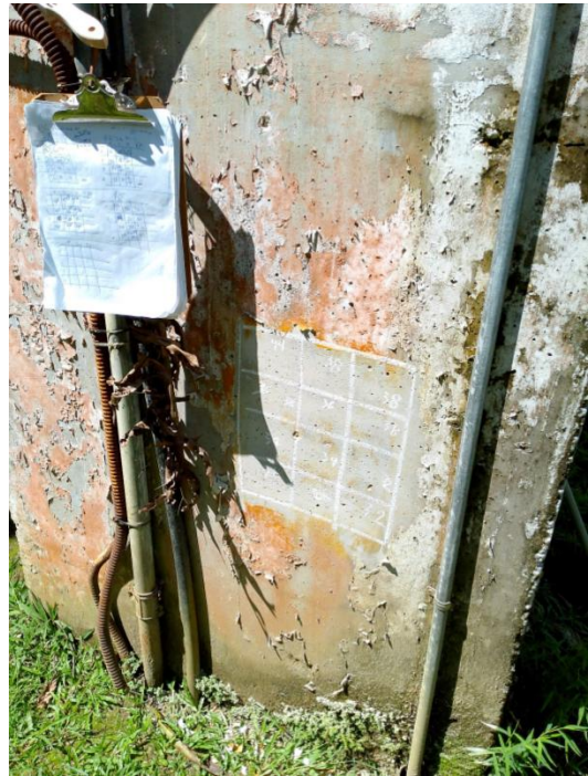
Fotografía. -Muro B, cuarto ensayo
