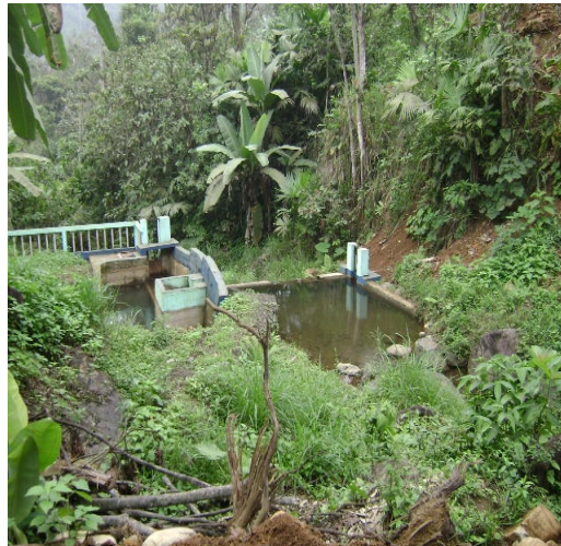
CAPTACION DEL AGUA.
