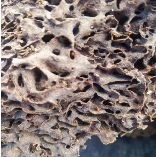
Inspección de termitas
