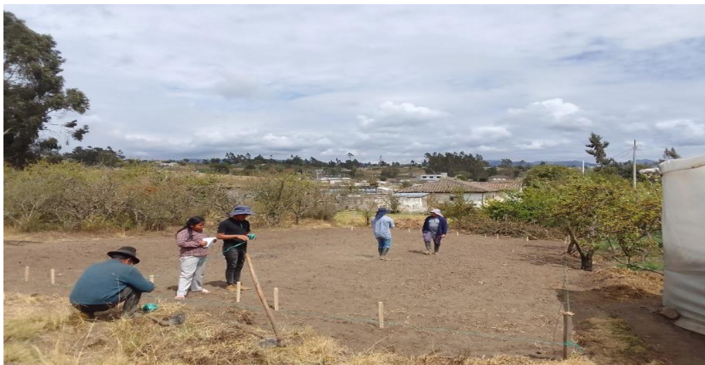
Nivelación del terreno
