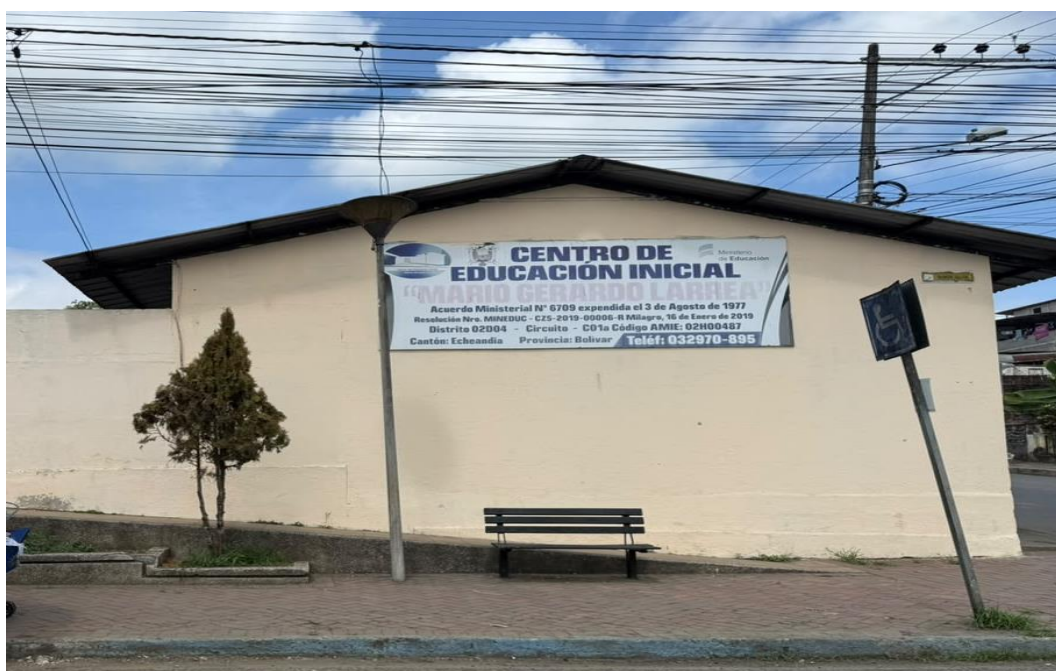
Fachada principal Centro de Educación Inicial Mario Gerardo Larrea
