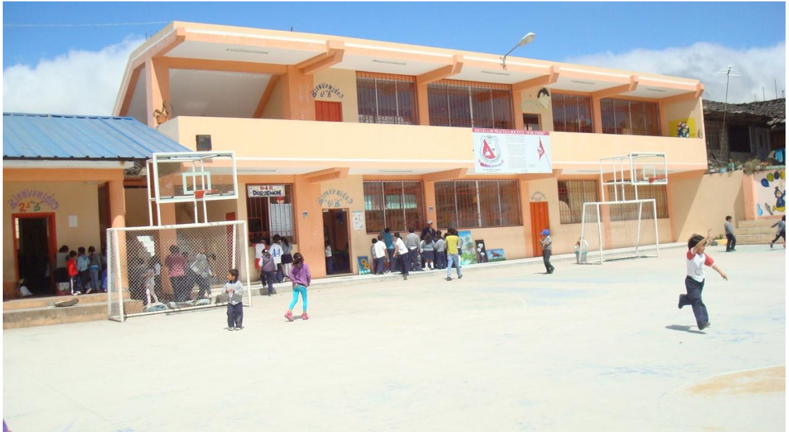
FOTOGRAFÍA N 4.- Fachada principal de la Escuela Fiscal Mixta “10 de Enero”.
