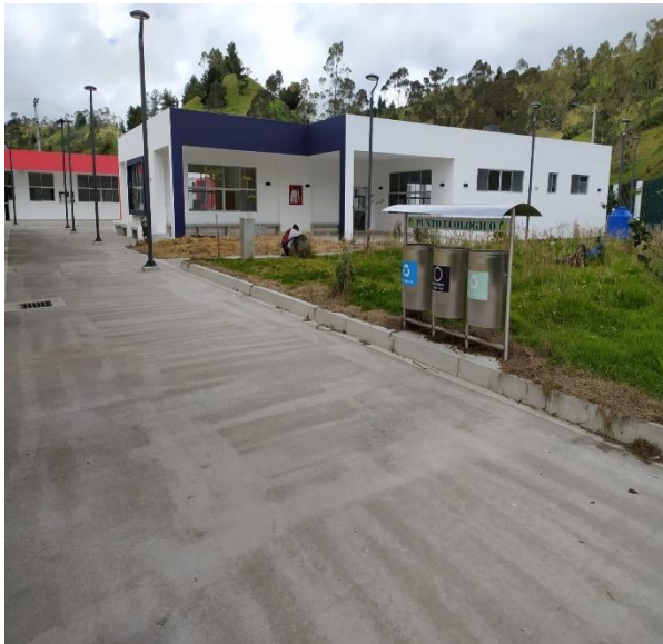
Fotografía 3: Observacion de donde se construirá el huerto.
