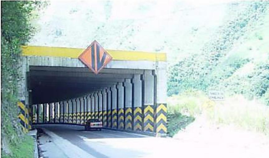
*Figura 42 Cubierta de protección para mitigar impacto de los bloques, Túneles de Quebrada Blanca (Suárez Díaz, Deslizamientos y estabilidad de taludes en zonas tropicales, 1.998)*
