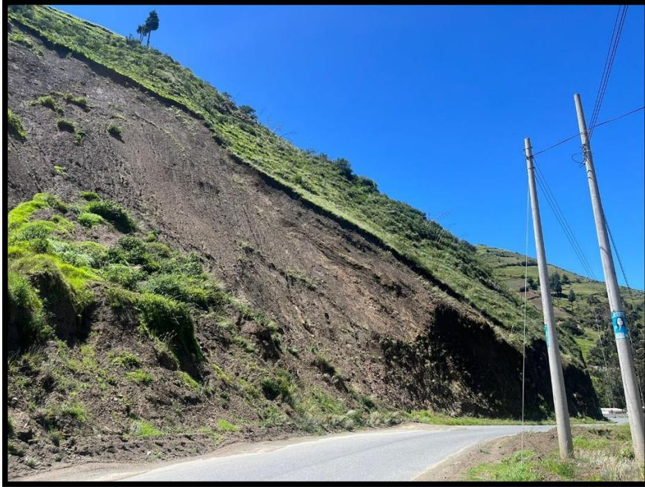
En el presente talud se puede observar que consta de una pendiente muy pronunciada la cual siempre existen deslizamientos que en muchas ocasiones tapan la vía impidiendo la circulación de los vehículos que se transportan a diario por la misma.
