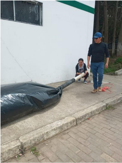
Armado del biodigestor
