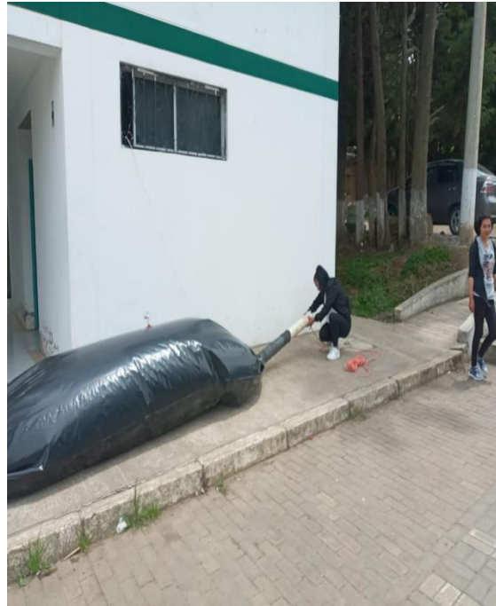
Pruebas pre instalación para evitar fugas
