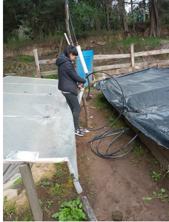
Instalación del Filtro
