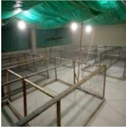
Foto 1: Adecuación del galpón
