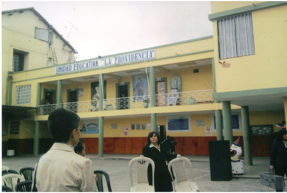
Fachada del patio de delante de la Unidad Educativa "La Providencia"
