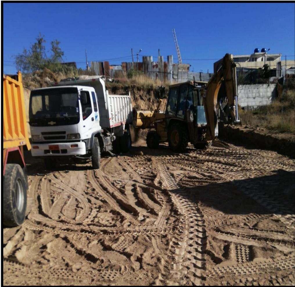
Los residuos de la construcción se recopilan en volquetas de la misma constructora y se transportan a lugares designados y autorizados por las autoridades municipales y estos desechos se retiran de la obra de manera inmediata puesto que cuentan con las maquinarias adecuadas para este proceso.
