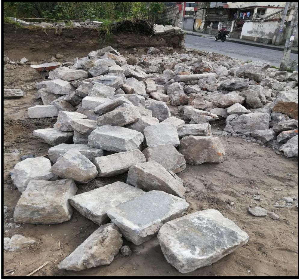
Se identifican materiales excedentes (escombros) de construcción que se encuentran almacenados a las afueras de las instalaciones de construcción con el propósito de ser transportados posteriormente a áreas designadas y autorizadas para la disposición de estos materiales, mencionando que estos escombros no se encuentran clasificados ya que se encuentran materiales como: botellas plásticas, cartones y papel.
