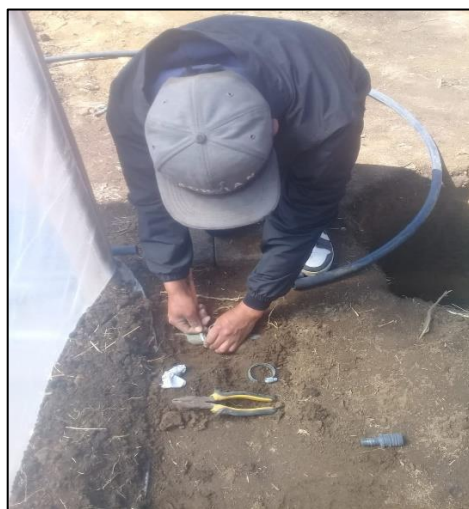
Instalación de la tubería principal
