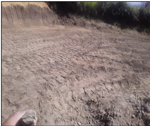
Nivelación del terreno
