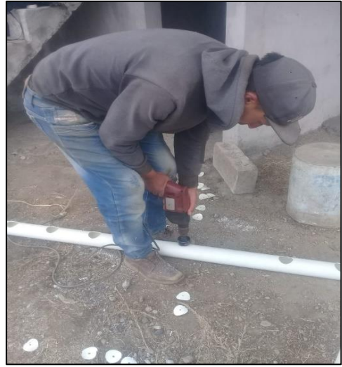
Perforando las tuberías de PVC
