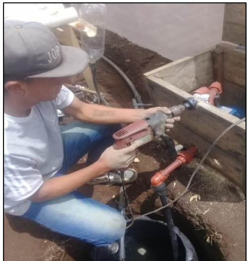
Protección de sistema de bombeo
