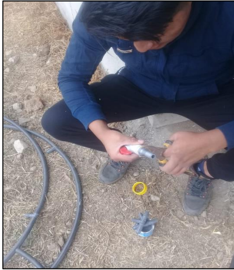
Instalación de llaves de paso ½ plg
