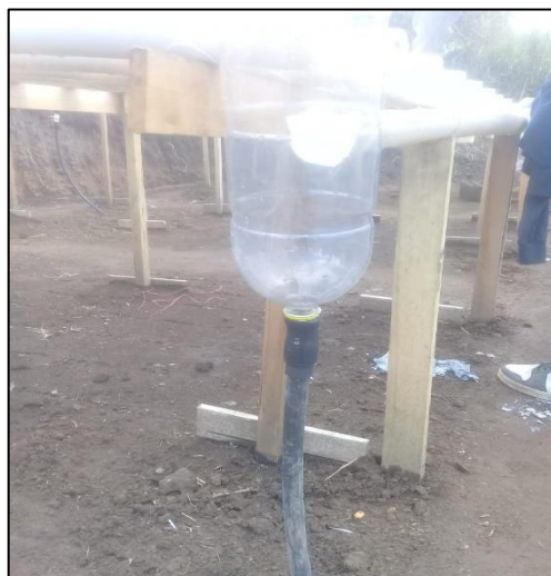
Instalación del canal de drenaje o retorno
