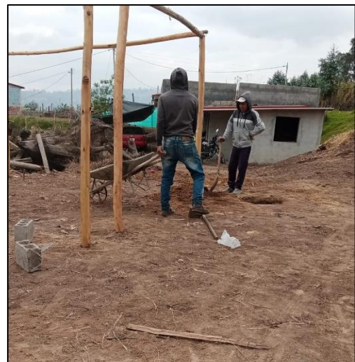
Colocando el tanque de almacenamiento
