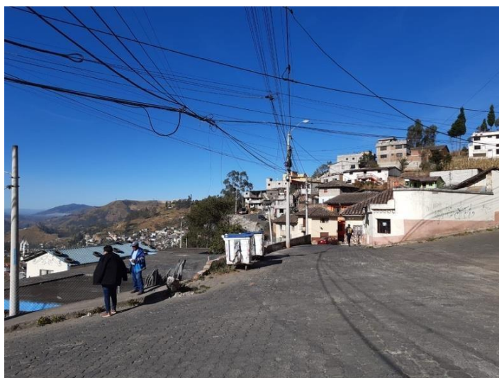
Fotografía 5 Acceso al barrio Los Tanques, por Cedillo, Pablo y Silva, Pablo, 2023.
