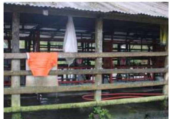
INSTALACIÓN DE ORDEÑO
