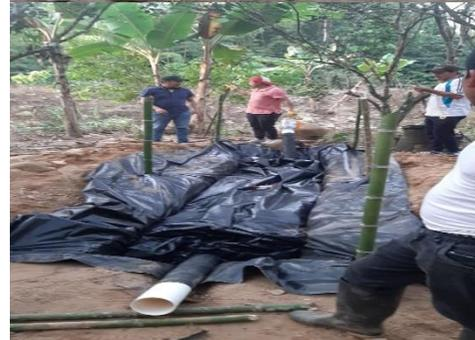
comunidad y el beneficiario, empezamos con la etapa de construcción en el cual según el diseño de 4 metros de largo por un ancho de manga de 1.5 metros, se procede a elaborar el biodigestor con ayuda de la comunidad la misma que aprende el proceso para luego replicarlo.
