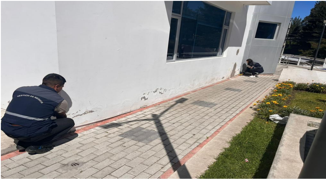
Foto 5: Medición del edificio
