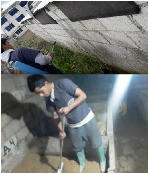
Limpieza y desinfección de las pozas
