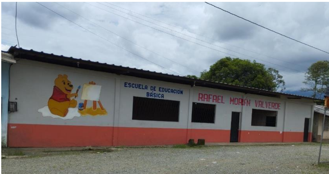
Anexo 5: Infraestructura de la “Escuela Rafael Moran Valverde”.
