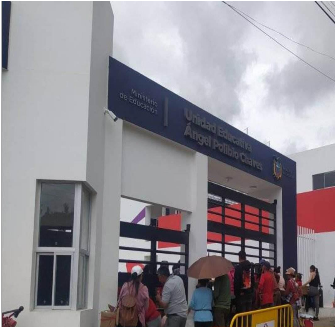
Figura 24 Infraestructura de la Unidad Educativa
