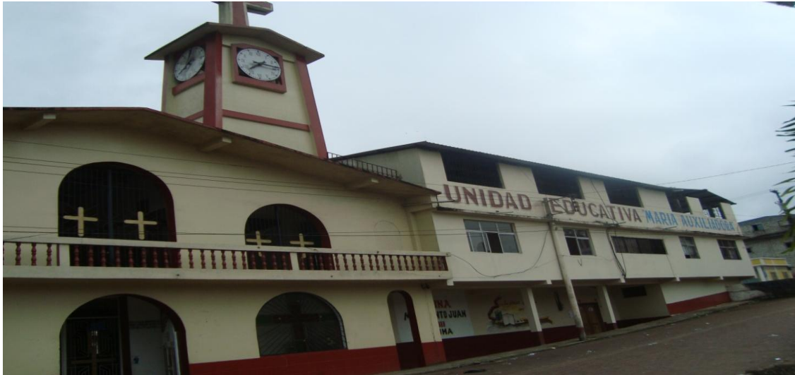
Fotografías de las instalaciones de la Unidad Educativa María Auxiliadora
