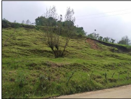
Ladera (talud) emplazada a lado derecho de la carretera en dirección San Pablo – Chillanes. Desde el pie a la zona superior de la formación, se extiende una amplia capa de pasto de kikuyo. En una parte del talud, ha iniciado un proceso de deslizamiento de tierra, debido a las fuertes precipitaciones que se han registrado en los últimos meses.
