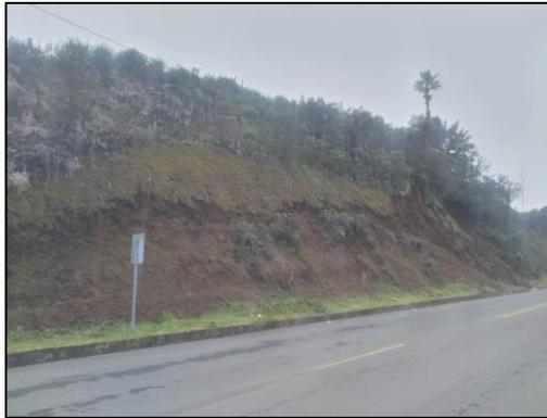
Talud artificial cuya composición del suelo presenta textura de clase franco arenoso, está emplazado junto al margen derecho de la vía Chillanes – Bucay. El cuerpo del talud es
