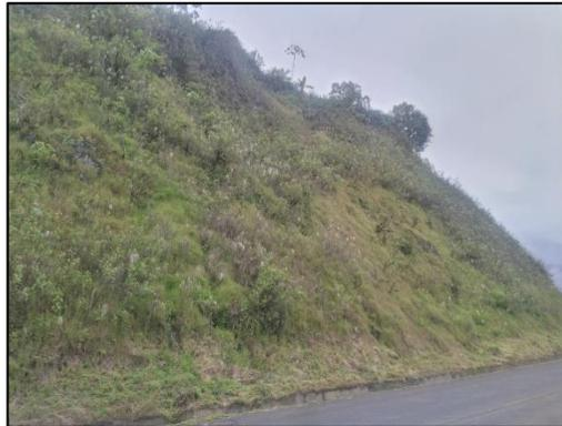
Talud artificial situado al ingreso a Bucay (General Antonio Elizalde), en el flanco derecho de la vía E 495. La forma de la estructura comprende una zona convexa y una parte semirrecta con pendiente superior a los 65° de inclinación. La composición del suelo muestra que esta es de tipo franco arcillo arenoso. En el cuerpo del talud predomina cobertura de pasto natural, especies de arbustos y algunos matorrales; la dimensión en longitud es de 31.49 m y en altura 29.89 m.
