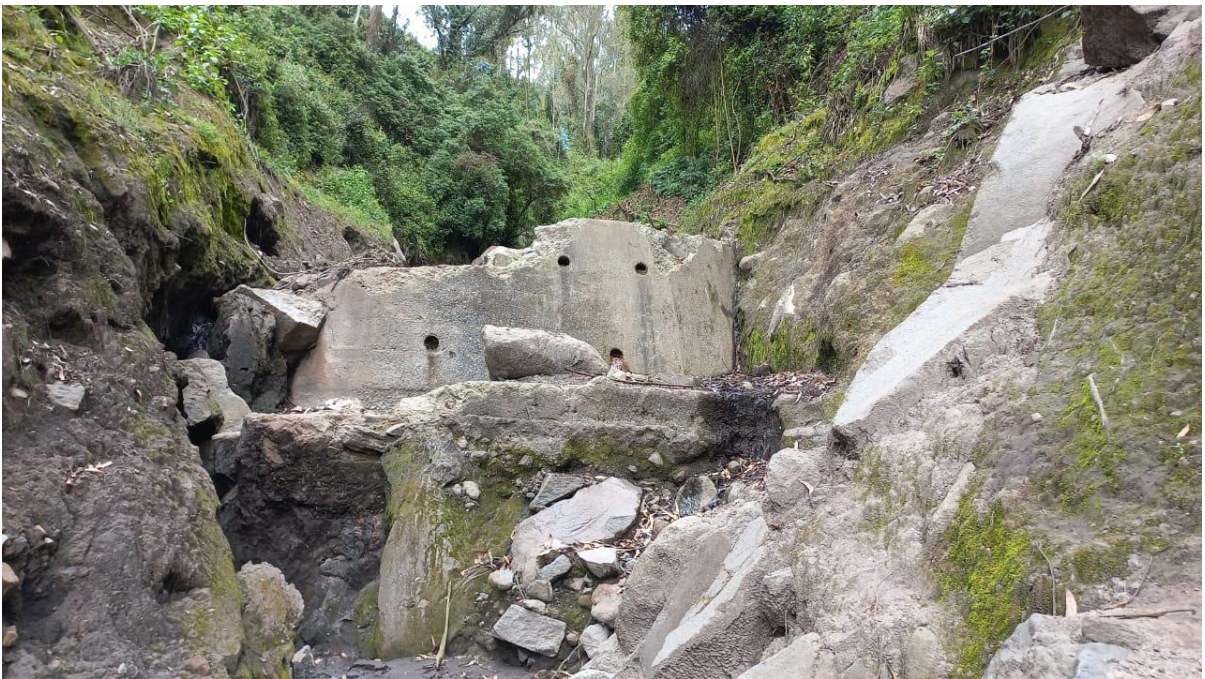
Ilustración 27 Muro destruido por el aluvión del barrio La Comuna, 09 de Marzo 2023
