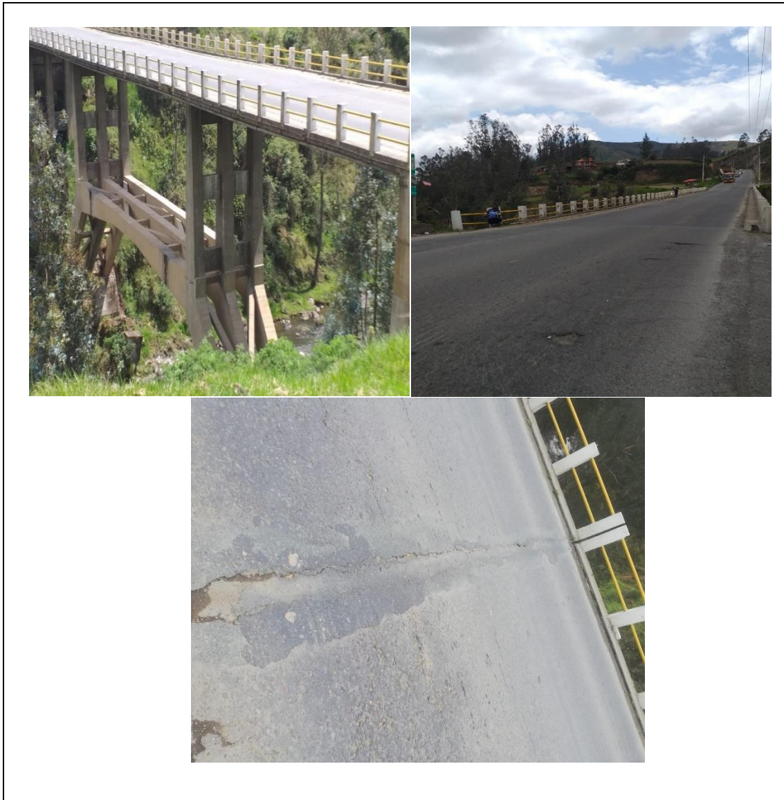
Fotografía N° 12. Superestructura – Puente vía Santa Fe.
