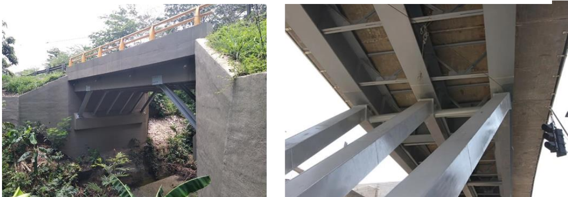
Figura 67. Subestructura metálica anclada a estructura de hormigón.
