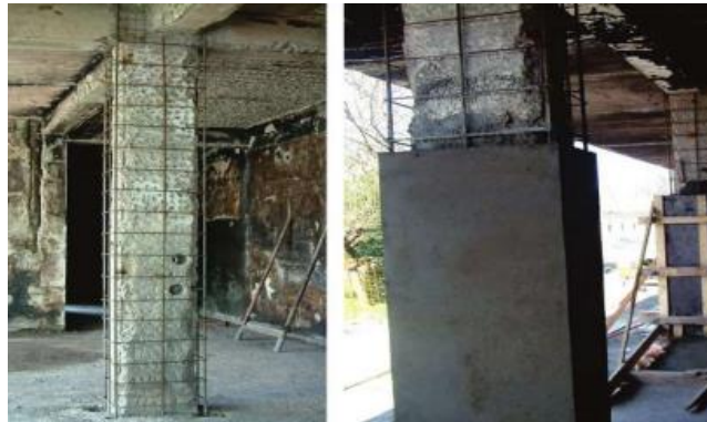
Figura 64. Encamisado de hormigón armado en pilares de un puente.
