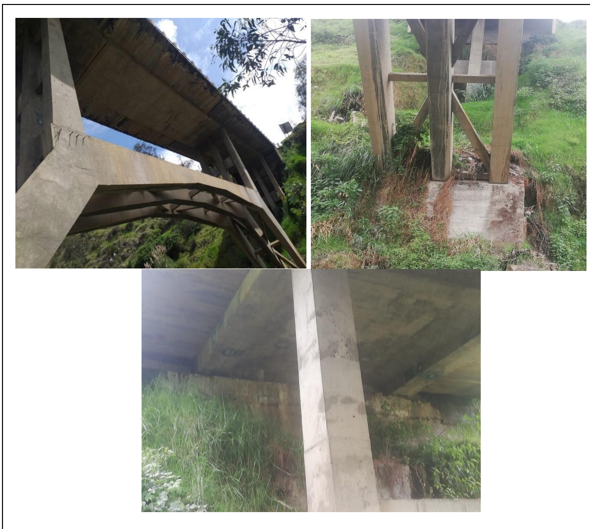
Fotografía N° 11. Subestructura – Puente vía Santa Fe.
