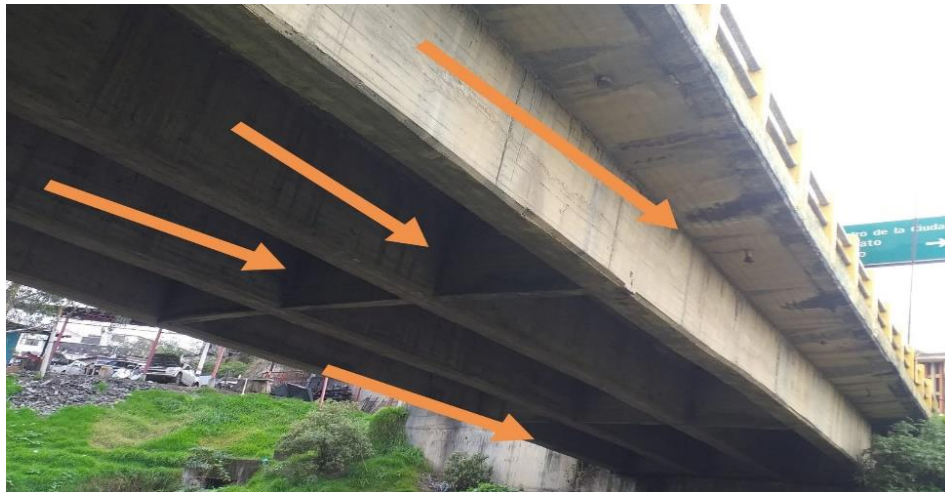
Fotografía N° 5. Superestructura – Puente vía Vinchoa.
