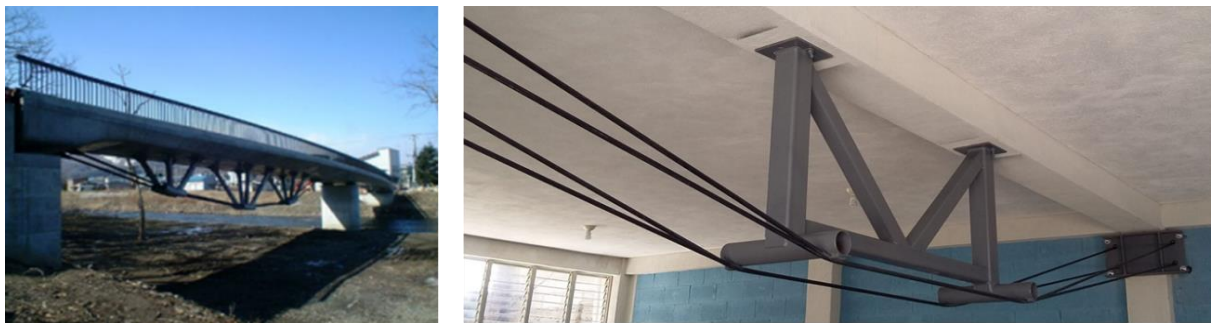
Figura 63. Postensado externo.
