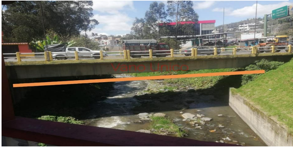
Fotografía N° 4. Trabes – Puente vía Vinchoa.
