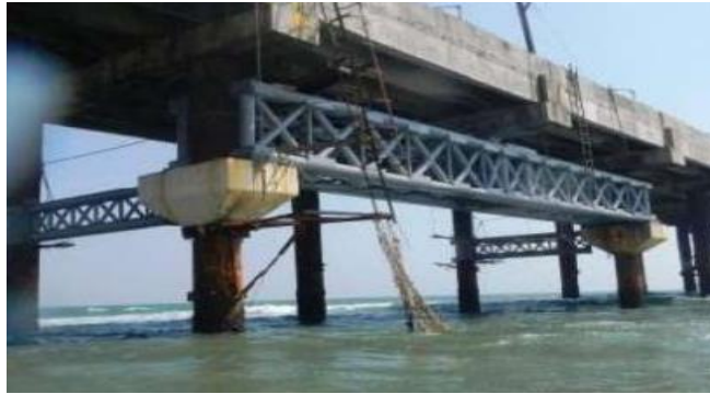
Figura 68. Celosía metálica implementada bajo el tablero de puente de hormigón armado.
