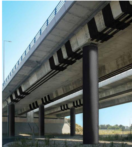
Figura 66. Reforzamiento de elementos estructurales de un puente con CFRP.
