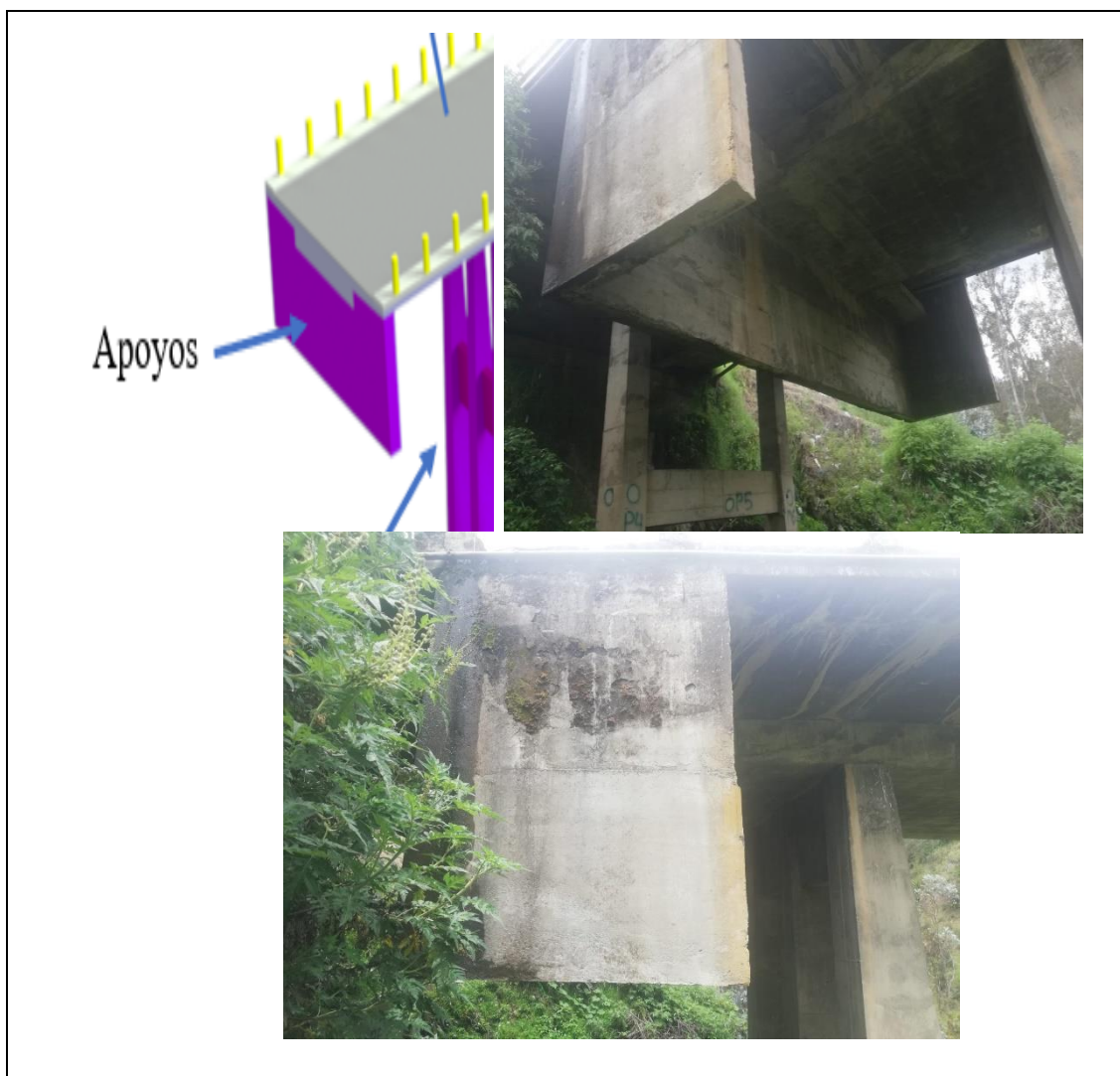
Fotografía N° 9. Apoyos – Puentes vía Santa Fe.
