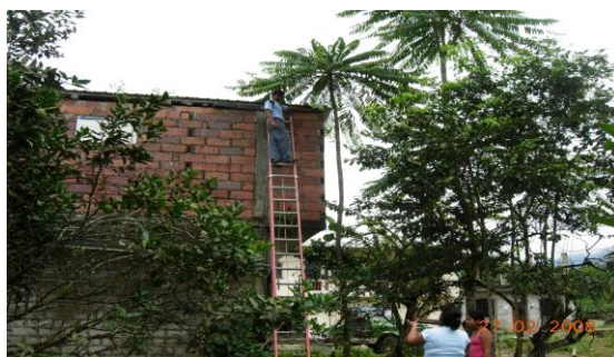
Minga con las madres para arreglo del techo.
