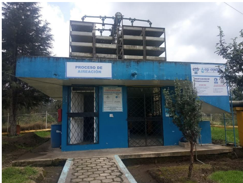
Fotografía 2 Torre de aireación
