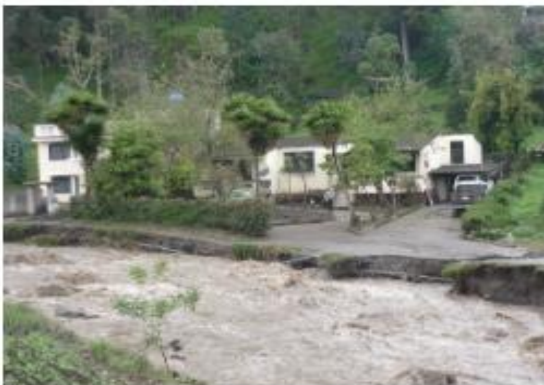
Afectación de crecida del río Guaranda, sector el Peñón 20-04-2012,
