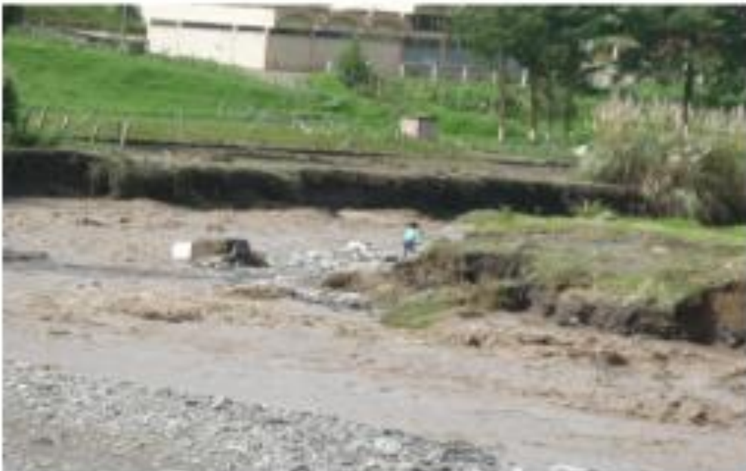
Afectación de crecida del río Guaranda, parte Sur del sector marco pamba 20-02-2012,
