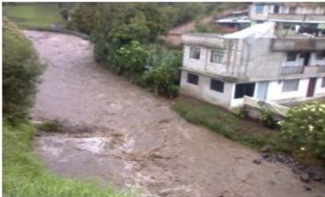
Afectación de crecida del río Guaranda, barrio los molinos 20-04-201
