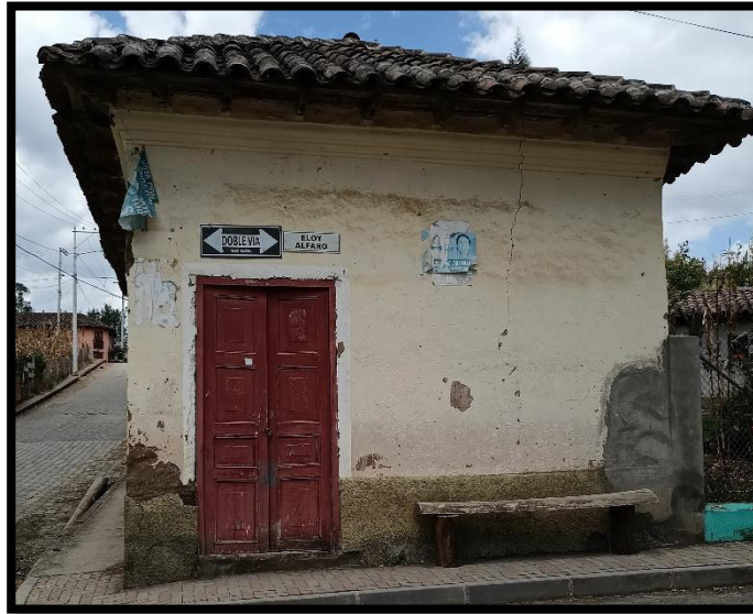
Ilustración 8: Vivienda de tipo Mampostería sin refuerzo
