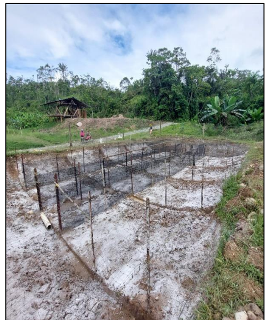
Diseño del estanque en un 50% de construcción Diseño de estanque terminado 100% caleado y desinfectado.
