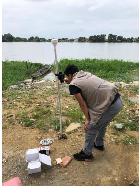
Fotografía 7,8 y 9. Visita a campo, puntos de control utilizando estación topográfica en el punto de desboca dura del Rio Babahoyo
