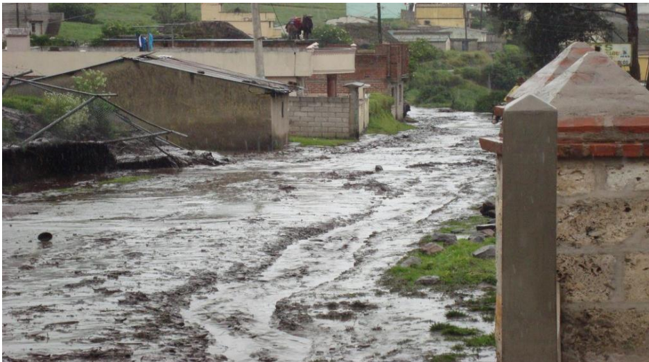
Foto 2 Escombros de inundación Quillan Playas Provincia de Tungurahua en domicilios cercanos a la quebrada que da al Río Ambato.
