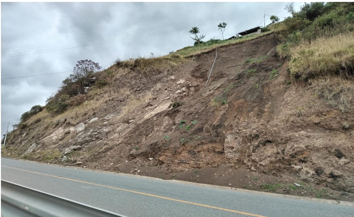
Fotografía 5: Taludes con desagües
