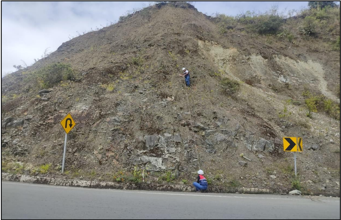
Fotografía N°. 5. Recolección y medición de puntos (longitud – altitud) de los taludes situados en la vía Chimbo – El Torneado.
