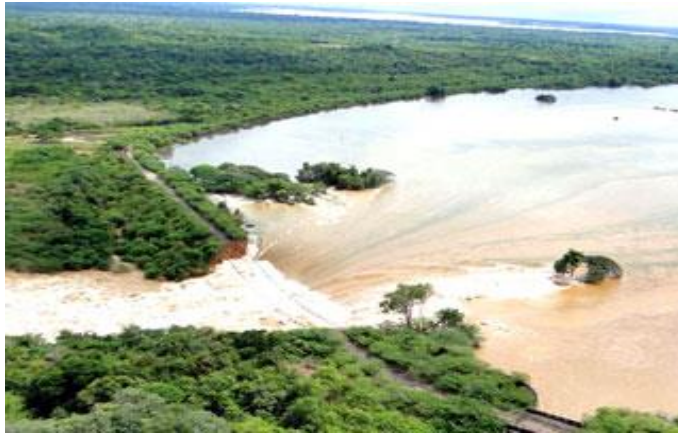
Figura 9. Inundaciones por rupturas de bordos.
