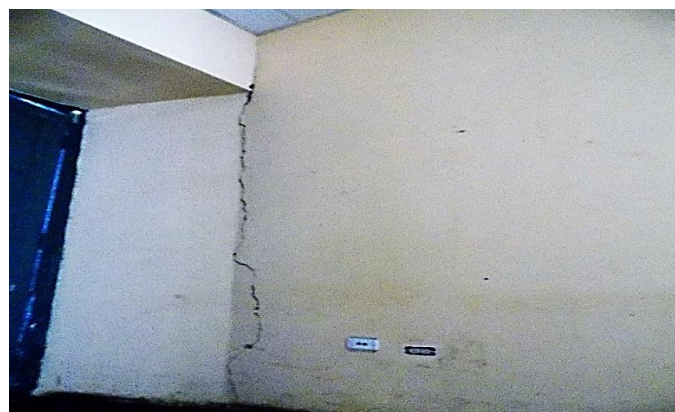
Figura 10. Fisura entre estructura principal y volado.
