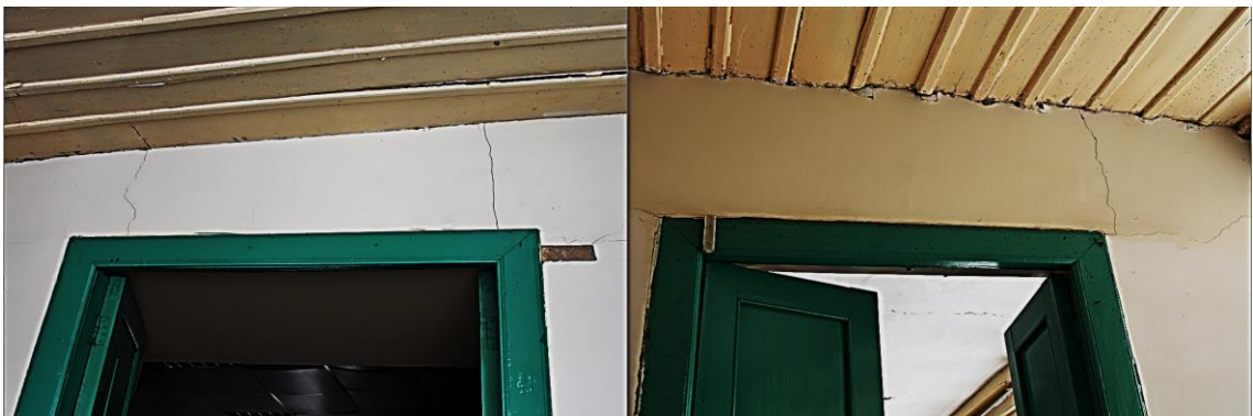
Figura 10. Fisura entre estructura principal y volado.
