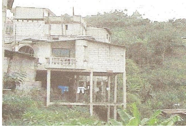
CASA CONSTRUIDA A LA ORILLA DEL RÍO CRISTAL
