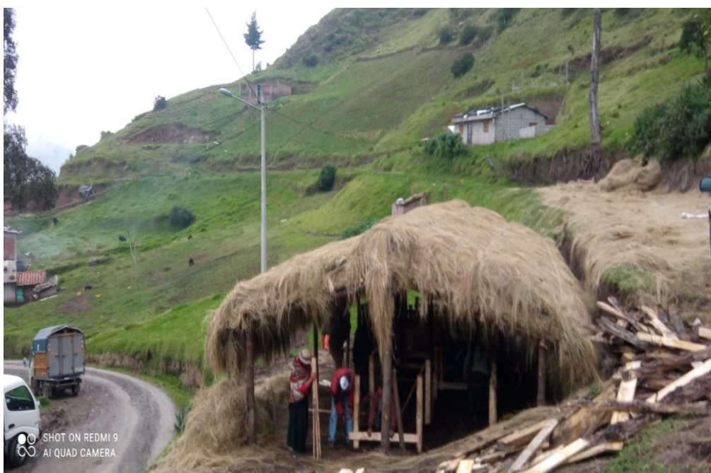
Fotografía 2. Elaboración del aprisco con paja del páramo y materiales de la zona
